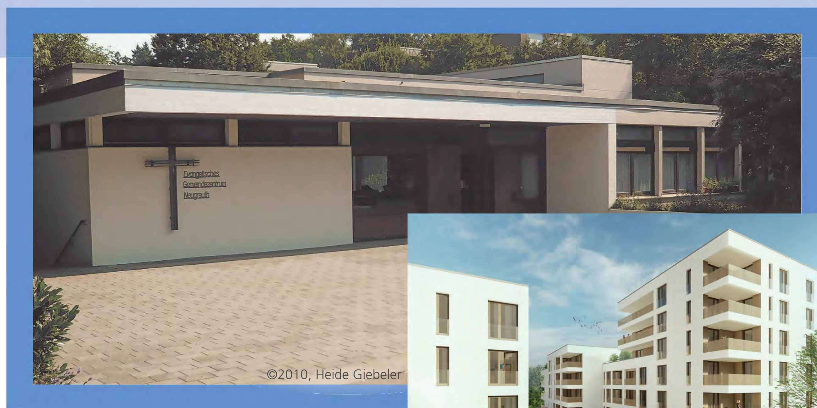
Altbestand mit Ev. Gemeindehaus
