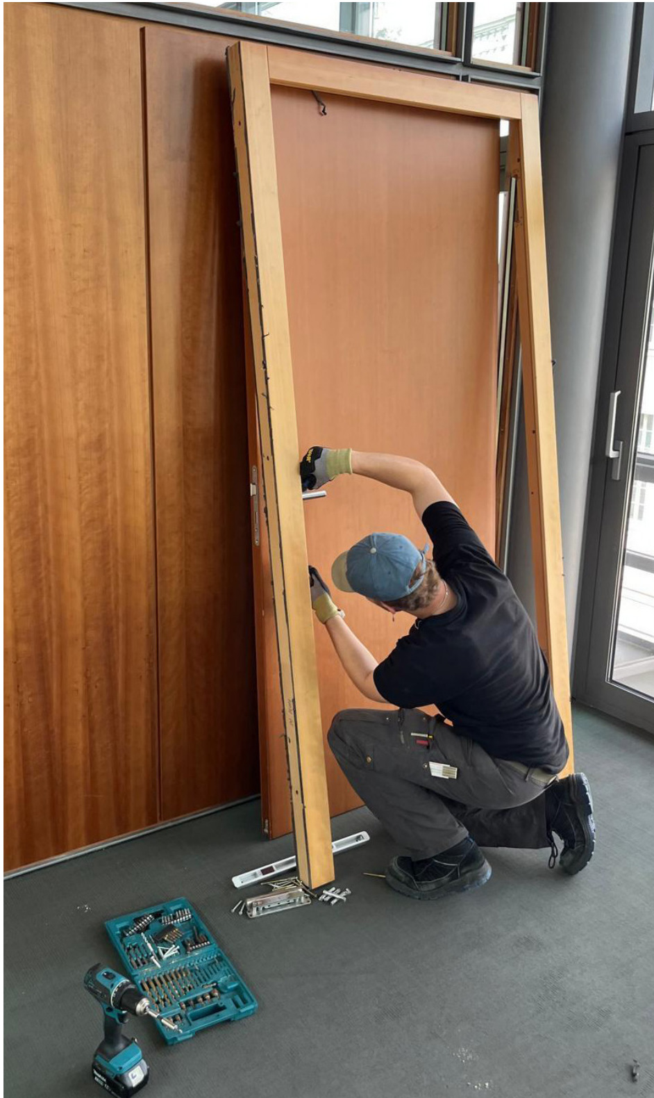
Foto 3: Zerstörungsfrei rückgebaute Brandschutztür mit verschraubter Blockzarge. Concular GmbH.
