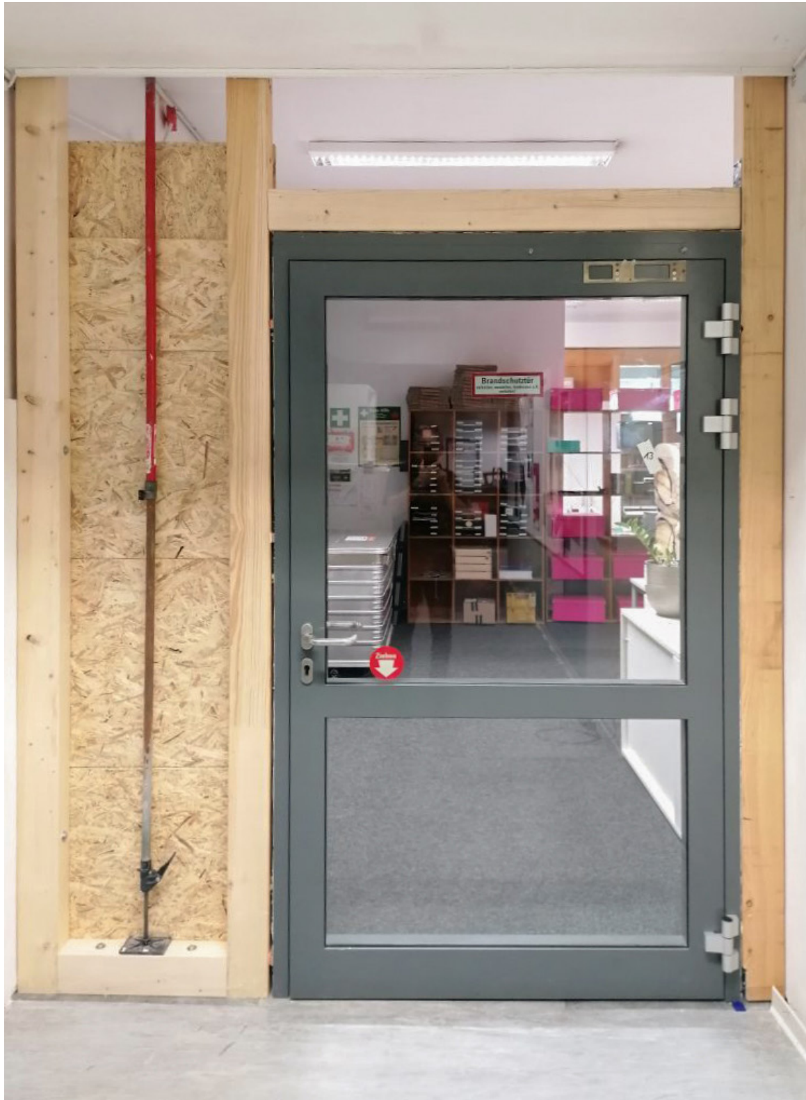
Foto 1: Brandschutztür beim Wiedereinbau. Concular GmbH.
