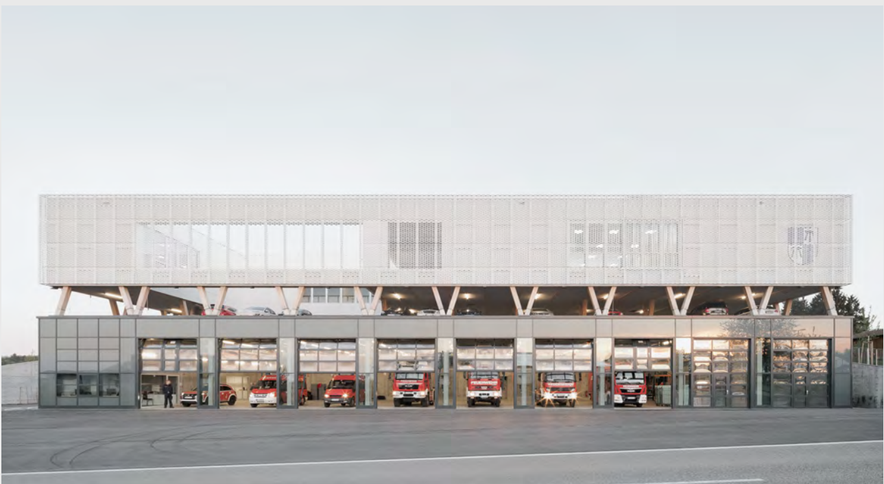
Außenansicht des Feuerwehrhauses in Straubenhardt
