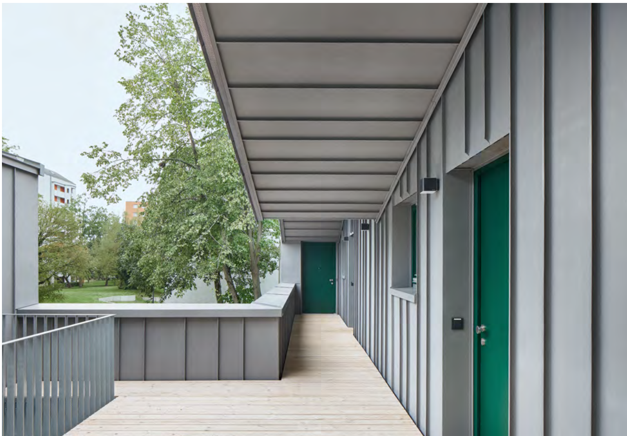
Laubengang der demontierbaren Garagenaufstockung in Karlsruhe (s. S. 62)
