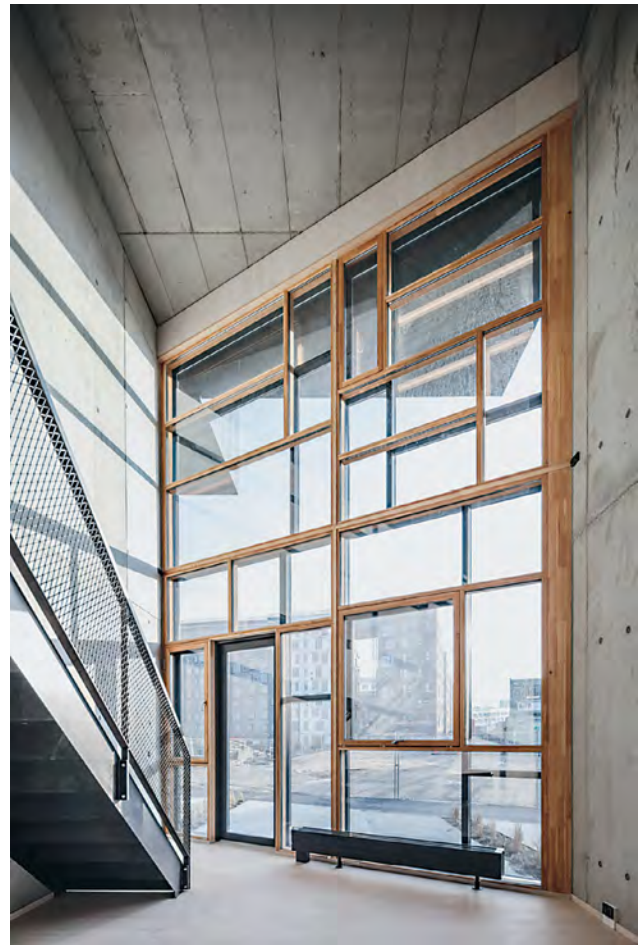
Doppelverglaste Fassade aus wiederverwendeten Fenstern in den Upcycle Studios in Kopenhagen
