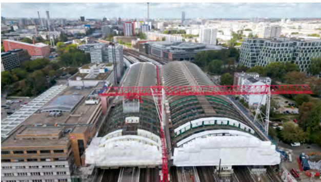
Luftbild des Ostbahnhofs in Berlin während seiner Sanierung
