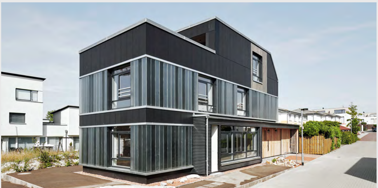
Außenansicht des Recyclinghauses in Hannover
