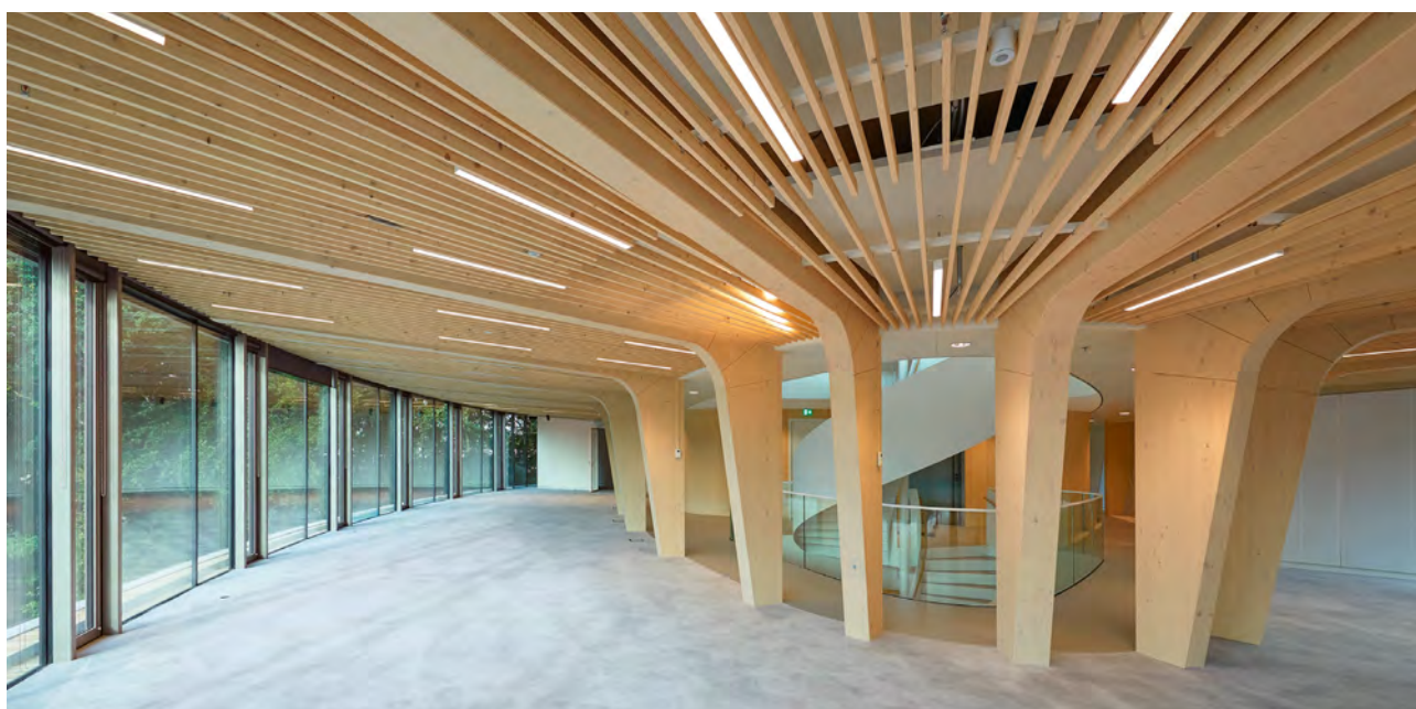
Demontierbare Holzträger und Oberflächen im Innenraum der Triodos Bank in Zeist
